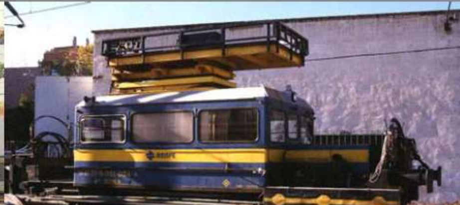
MANTENIMIENTO DE VIA
